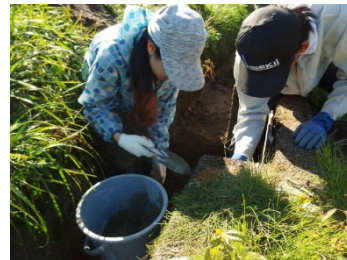
<鳥取県鳥取市 (Rモデル事業)> 地方の農業に関心のある都市部からの 滞在者との協働による農業用水路の修繕
