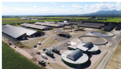
酪農施設（搾乳設備）
