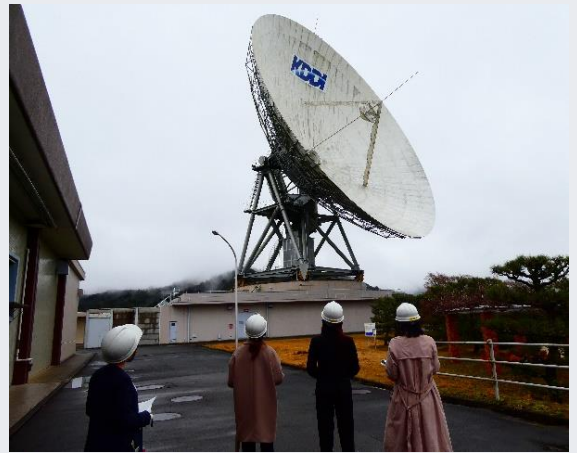
衛星通信施設
