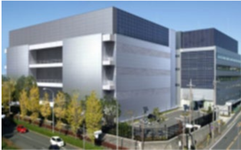
図 2.2.1-11 富士通横浜センター外観
