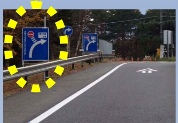
分岐点の手前側に新たに設置された標識
