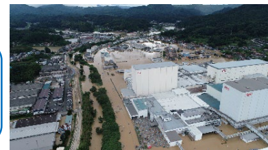
被災の様子（写真提供：国土交通省中国地方整備局）
