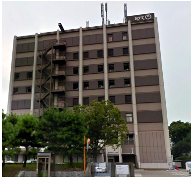
NTT 東日本 つくばビル (素晴らしい 聖地) 筑波大学もこのビルの配下
