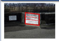
写真(左)は、治水対策で、堤防と堤防の間に設置された陸閘。閉鎖の際に必要な人数は2人程度で、金属製の板三枚をはめ込み、約10分で閉鎖できる
