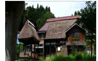
再生古民家「平左衛門」
