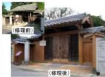
ワンコイントラストで修理が実現した井上勝彦旧門
