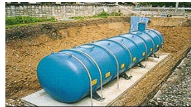
【耐震性貯水槽】
