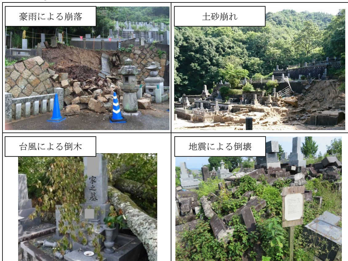
図 2-(1)-③ 公営墓地・納骨堂の被災例
