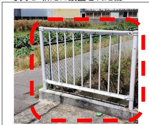
写真1 新たに設置された柵
