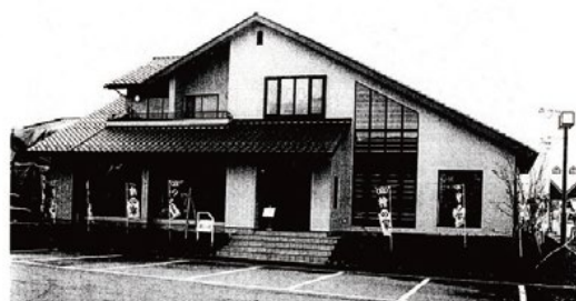
被告住宅 玄関側の外観
