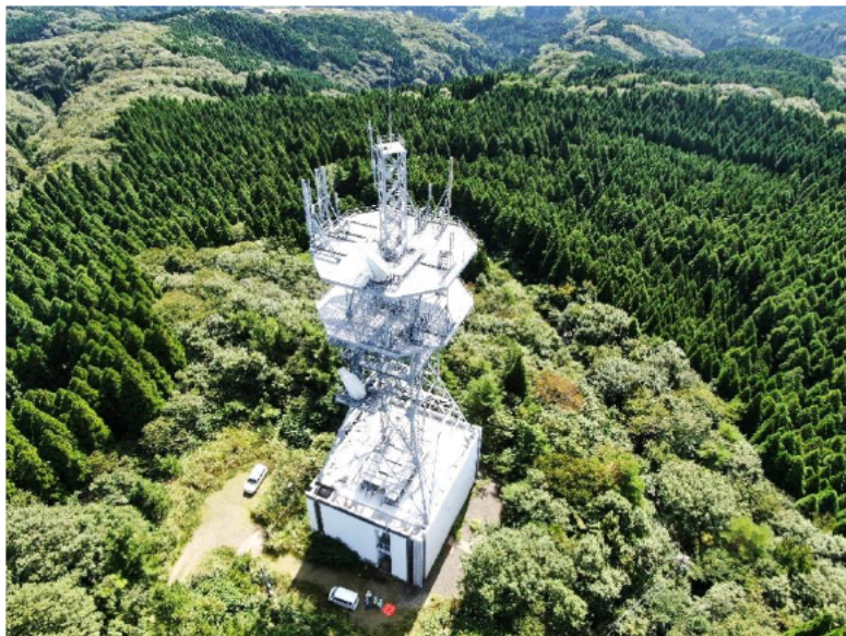
通信設備点検
