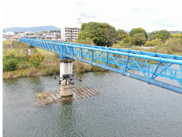
水道施設点検
