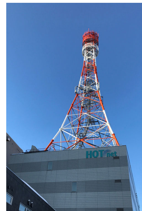
HOTnet ネットワークセンター外観
