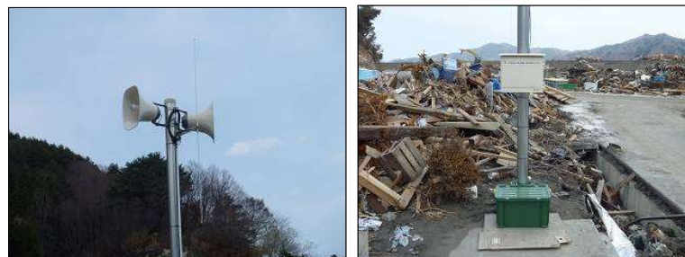
仮設柱を新設利用
