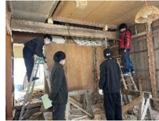
▲空き家改修作業の様子
