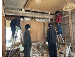
▲空き家改修作業の様子
