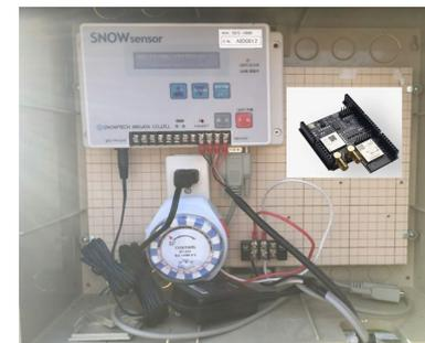
排水路 水位・雨量計測(7箇所)
