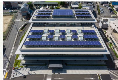
太陽光発電 (159kWh)
