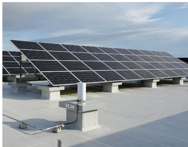
太陽光パネルの設置
