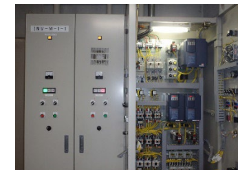
給排気ファンのインバータ制御
