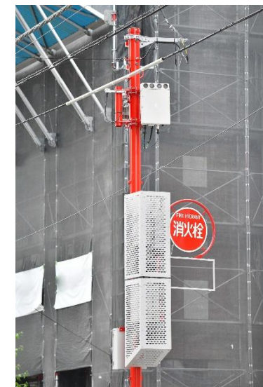
消火栓標識型基地局（サブ6）の例
