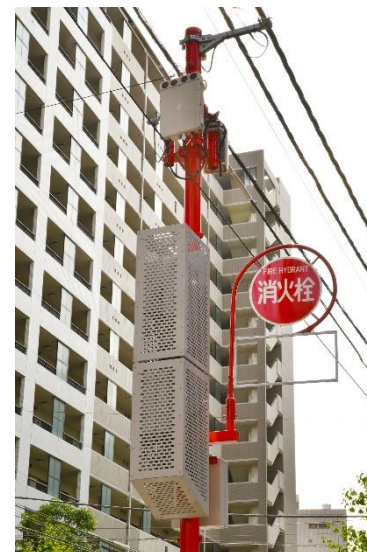
消火栓標識型基地局（サブ6）の例
