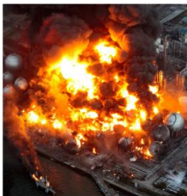
炎を上げて燃えるコスモ石油千葉製油所。2011年3月11日午後9時36分、千葉県市原市、本社ヘリから
