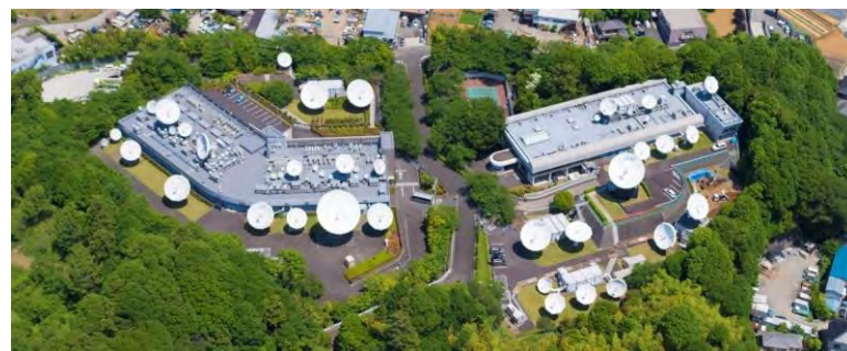
写真：スカパーJSAT(株)横浜衛星管制センターの外観図
