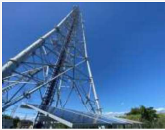
太陽光発電を電源にした基地局
