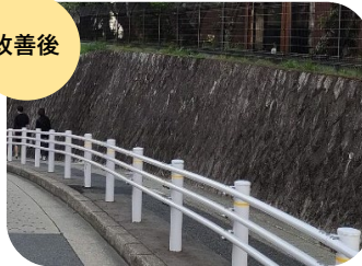
電柱が設置されていた箇所
