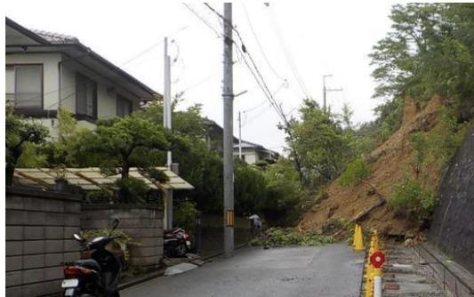
2014年、豪雨の影響で豊能町木代にある擁壁の一部が崩壊し、大量の土砂が崩落し府道や棚田に流れ込む災害が発生した。豊能町には昭和40年前半より大規模開発された住宅地などに存在する町管理の擁壁の老朽化が進んでいる。近年、全国的に豪雨や台風の大型化など大規模自然災害が多発しており、豊能町においても住民の安心、安全の確保が重要となっている。令和3年度に「豊能町強靱化計画」を策定し、災害への対策に取り組んでいる。
