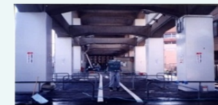
高架橋の耐震対策
