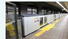
可動式ホーム柵の設置
