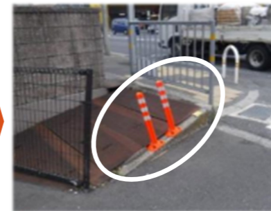
【After】交通量が多い場所でしたが、安全対策が講じられました。
