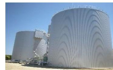
汚泥消化施設の導入によるバイオガス発電
