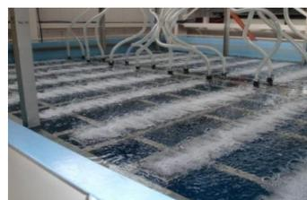
超微細散気装置導入による省エネ化
