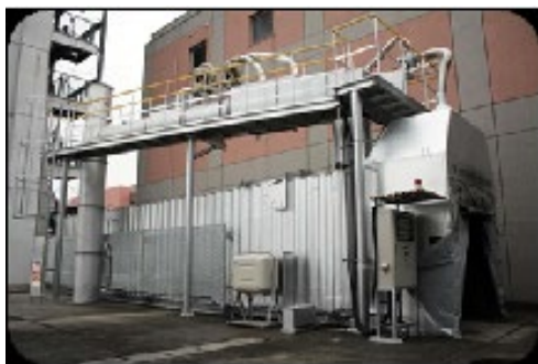
実火災体験型訓練施設
