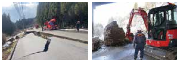
道路状況と重機で啓開する様子（大阪府消防局提供）
