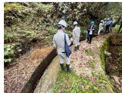
現地調査の様子
