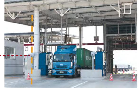
港湾RFID用エンテロゲータの設置地上高を4mを想定、アンテナ指向性特性を考慮
