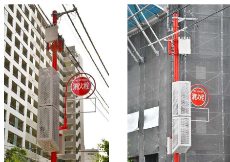
消火栓標識型基地局（サブ6）の例
