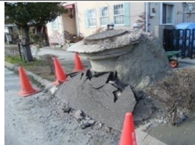
液状化によるマンホールの浮上(千葉県浦安市・東日本大震災)
