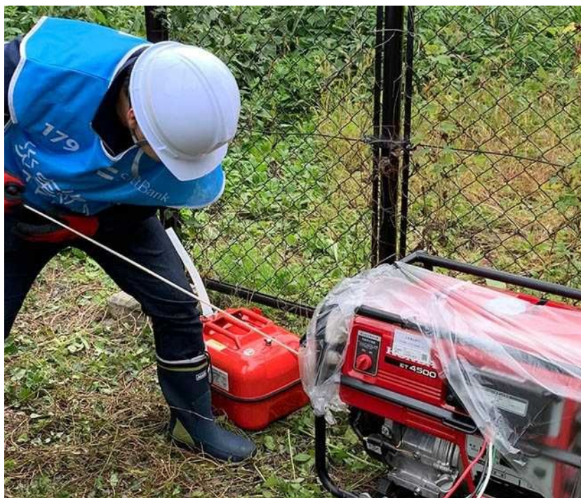
従来型可搬型発電機
