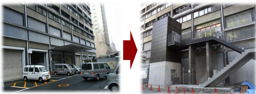
1階の開口部閉塞、2階に玄関の設置
