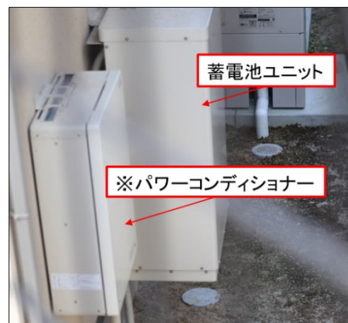
妨害源のパワーコンディショナー (※)太陽光パネルで作った直流電気を 交流に変換する装置
