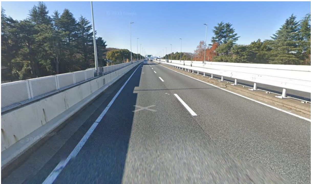
図 3-12 区間③西側区間の都立赤坂公園に隣接する区間(高さ 1.5m の金属製遮音壁)
