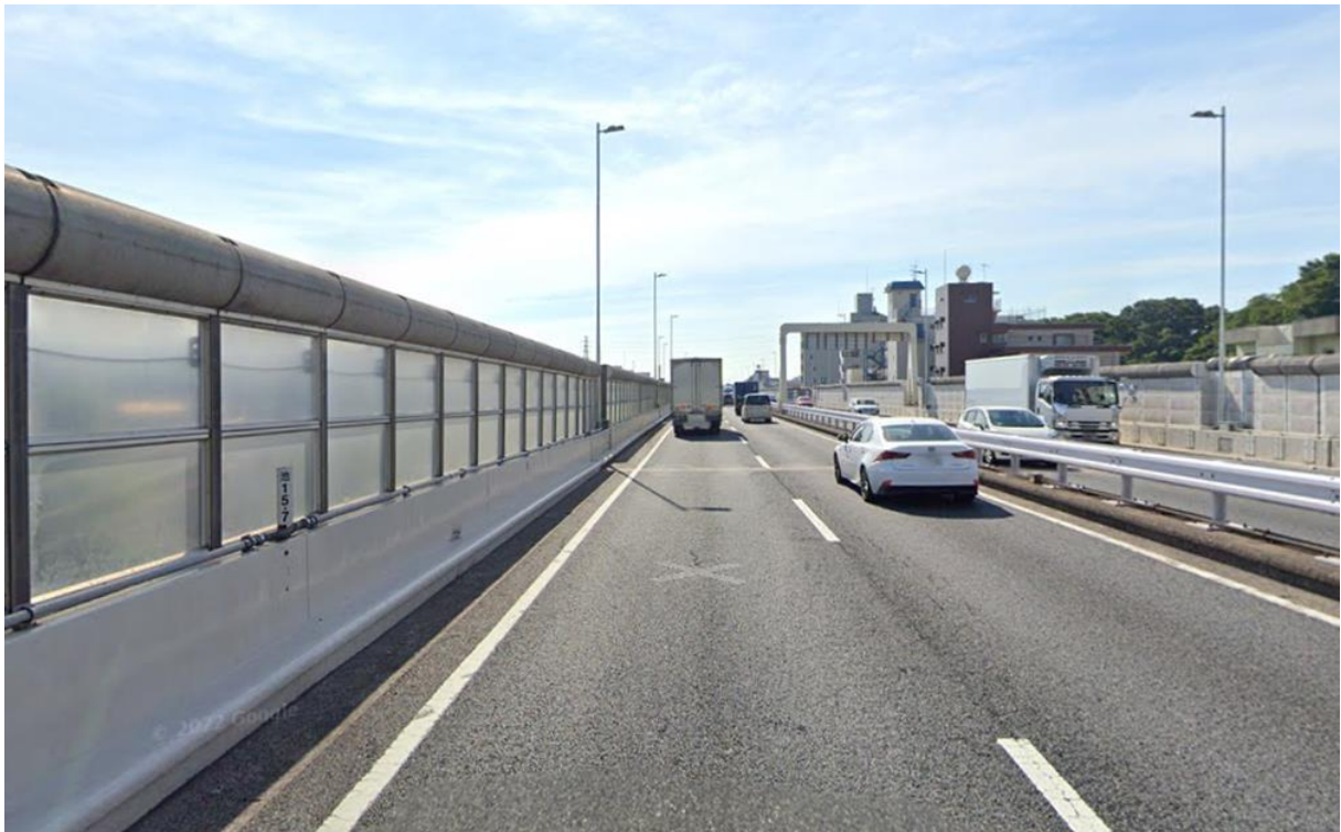
図 3-13 区間③北側上り車線の道路端(高さ 3m のポリカーボネート製遮音壁)
