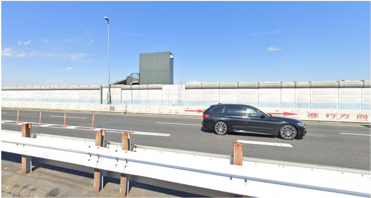
図 3-11 区間③東側区間下り車線の道路端(高さ 3m の金属製遮音壁)
