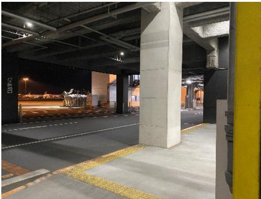
図 3-35 ボーディングブリッジ下の閉空間スペース①
