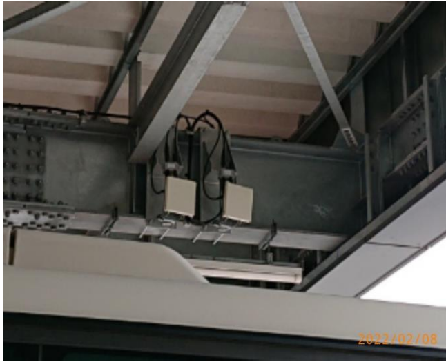
图 2-10 Site3-1 基地局設置写真
