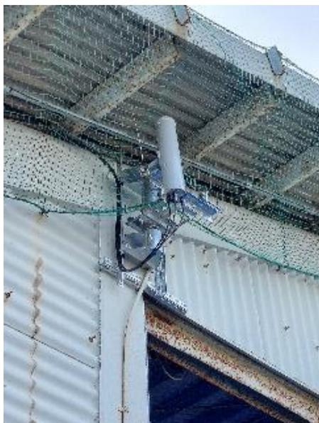
図 2.3.1.1-4 セクタアンテナ外観
