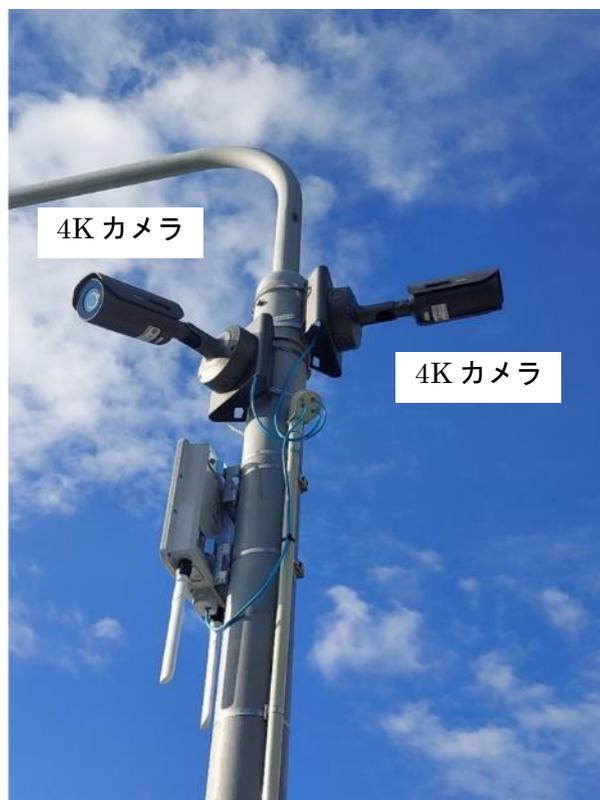
図 2.2.2.3-3 4K カメラ (栈橋先端)
