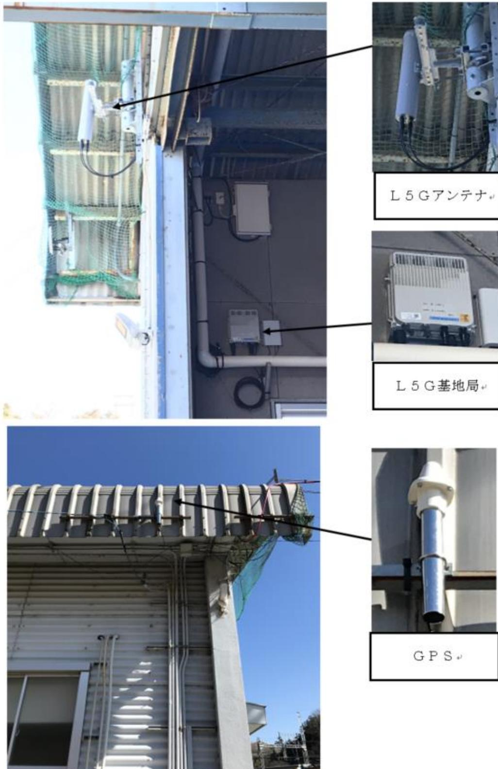
図 3.2-4 ローカル 5G 基地局と GPS アンテナの設置状況 (艇庫\_屋外)
