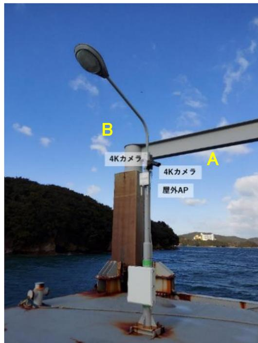
図 4.3-2 4K カメラ設置位置 (A・B)
