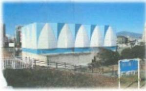
台風等によって降水量が増えた場合や、河川の水位が上昇した場合は、自然流下で雨水の放流が出来なくなるため、ポンプ場で雨水をくみ上げて、大きな浮遊物を取り除いたのち、河川へ放流することで、市街地が浸水することを防止しています。
