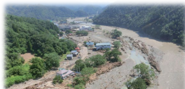
H28年台風第10号による災害
