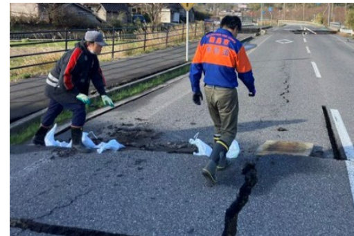
1月2日、輪島市門前町において、輪島市消防団が、道路の亀裂部分に土を埋め、通行を可能とする応急対策を実施
