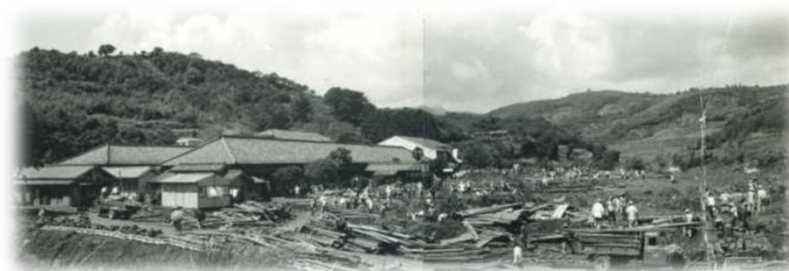
（7.8災害により被害を受けた大浦小学校）
