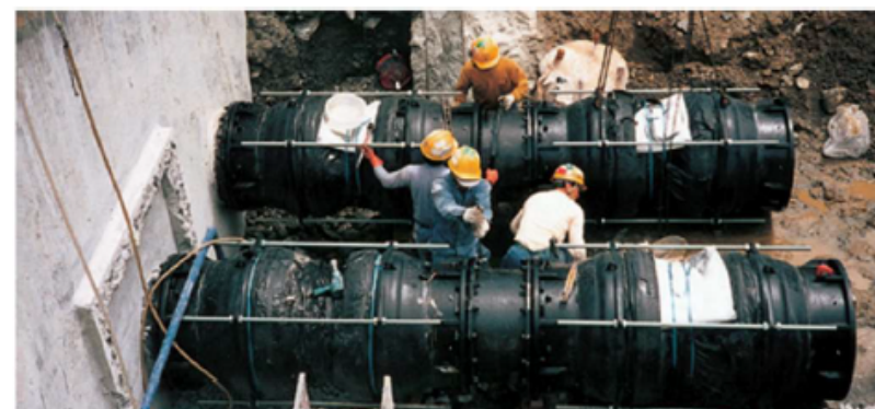
耐震継手管被災状況(被害無し)
