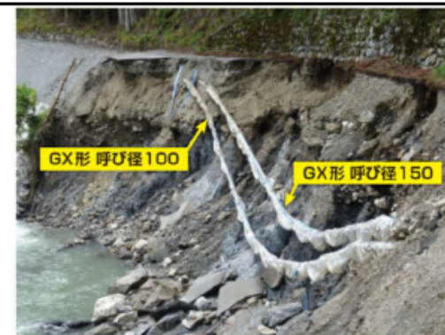
耐震継手管被災状況(被害無し)
