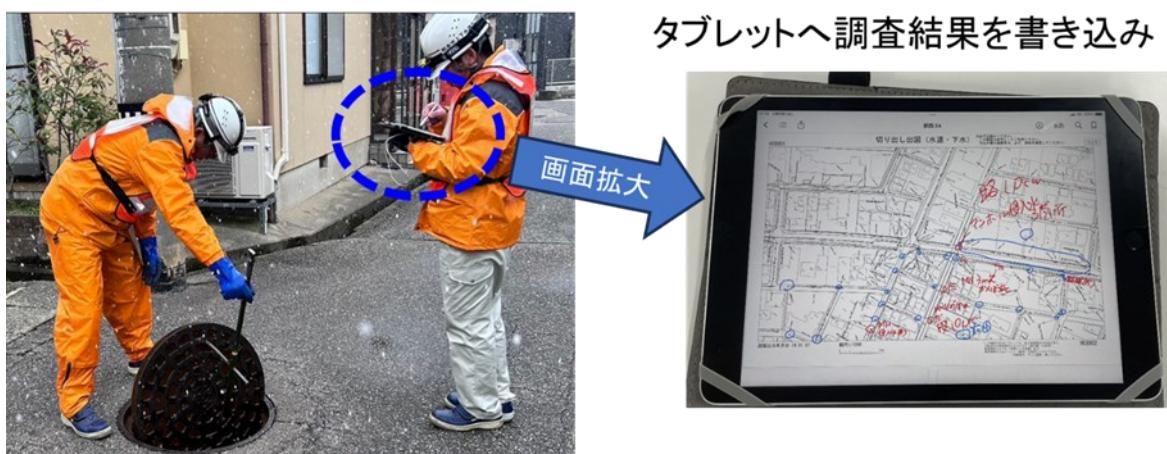
図 5－1－3 下水道施設被害調査におけるデジタル技術活用事例
