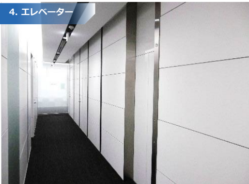
4. エレベーター
