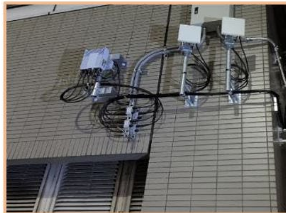
RU装置および北向きアンテナ
